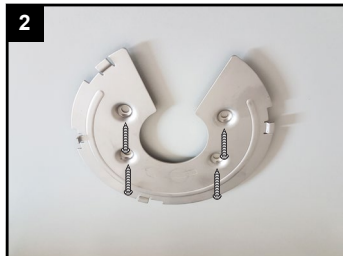
2 Montageplatte an die Decke befestigen und Kabel verbinden, siehe Kapitel [Verkabelung].
