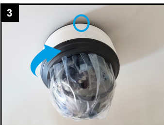
3 Kamera an Montageplatte drehen und Feststellschraube festziehen.
