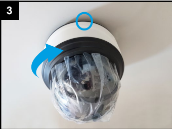
3 Kamera an Montageplatte drehen und Feststellschraube festziehen.
